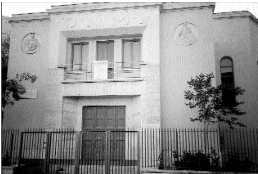
La palazzina ONMI di Piazza Celli, la prima sede del nostro Ordine
