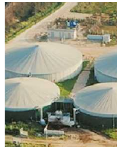
Un esempio di centrale biogas
